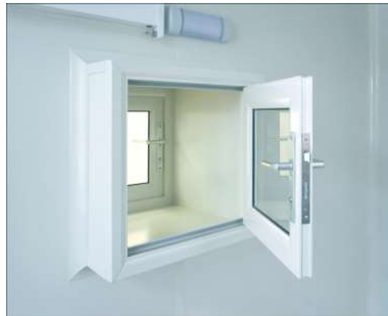
Гермицидный шлюз: заранее подобрать его размер (клетки!, приборы!) и конфигурацию смежных комнат (стол с лампой, емкости для замачивания, для отходов)
